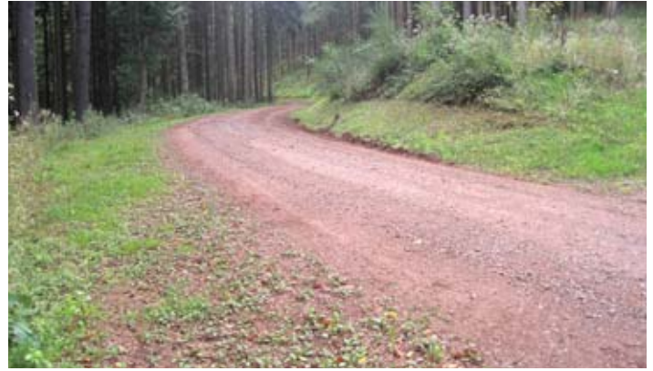
Bild 3: Ein Holzabfuhrweg nach dem Einsatz eines Anhängegräders mit perfekt ovalem Profil.
