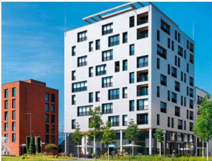
Mit einer Höhe von 34 m steht im neuen Heilbronner Stadtteil „Neckarbogen“ das derzeit höchste Holz-Hybrid-Gebäude Deutschlands. Skaio, so sein Name, setzt sich aus zwei Teilgebäuden zusammen: Dem eigentlichen Zehngeschosser mit Außenabmessungen von etwa 23 m auf 23 m und einem daran anschließenden, zurückgesetzten Sechsgeschosser.
